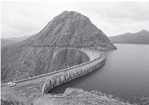
La diga di Idduki
